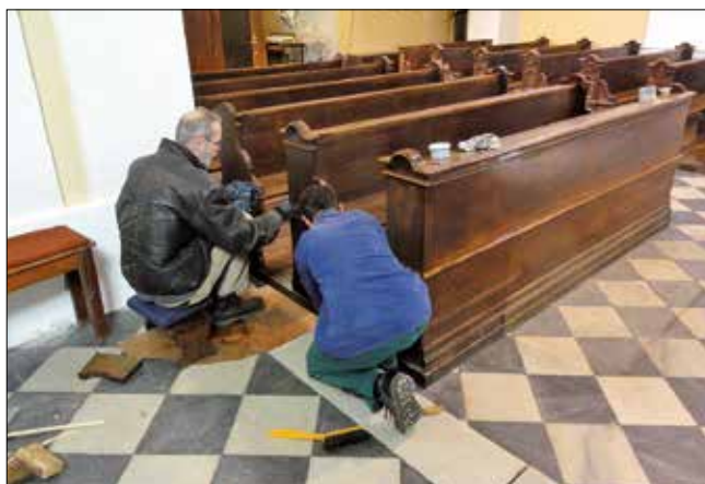
Firma Dřevodílo - Tomáš Sysel provedla během jarních měsíců rekonstrukci dřevěných lavic v kostele.
