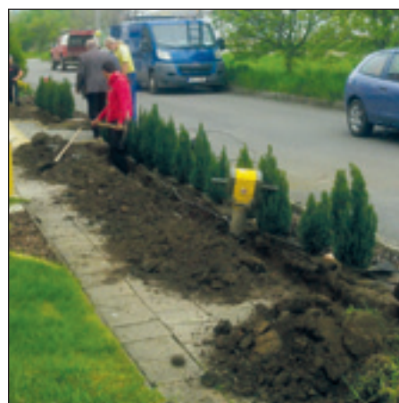
Kabelizace v ulici zbrojnicí.
