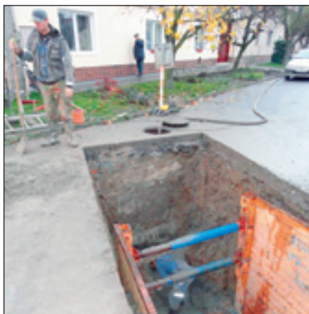
Oprava kanalizace u č.p. 161.
