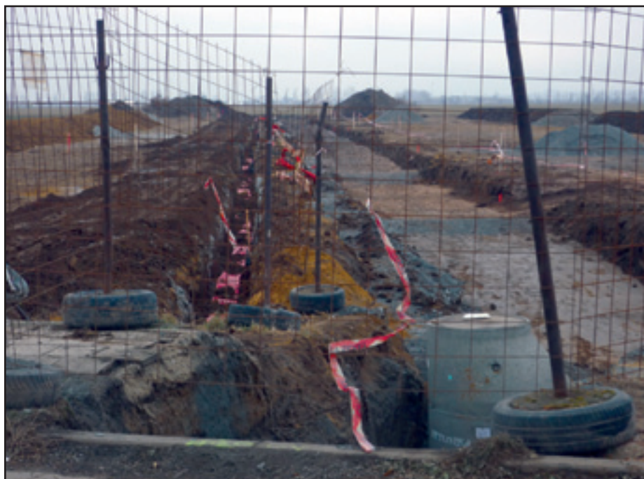
Pokládání inženýrských sítí k nové výstavbě rodinných domů.
